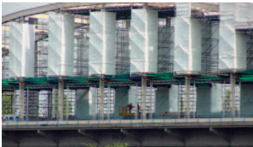
Een brug in de steigers
